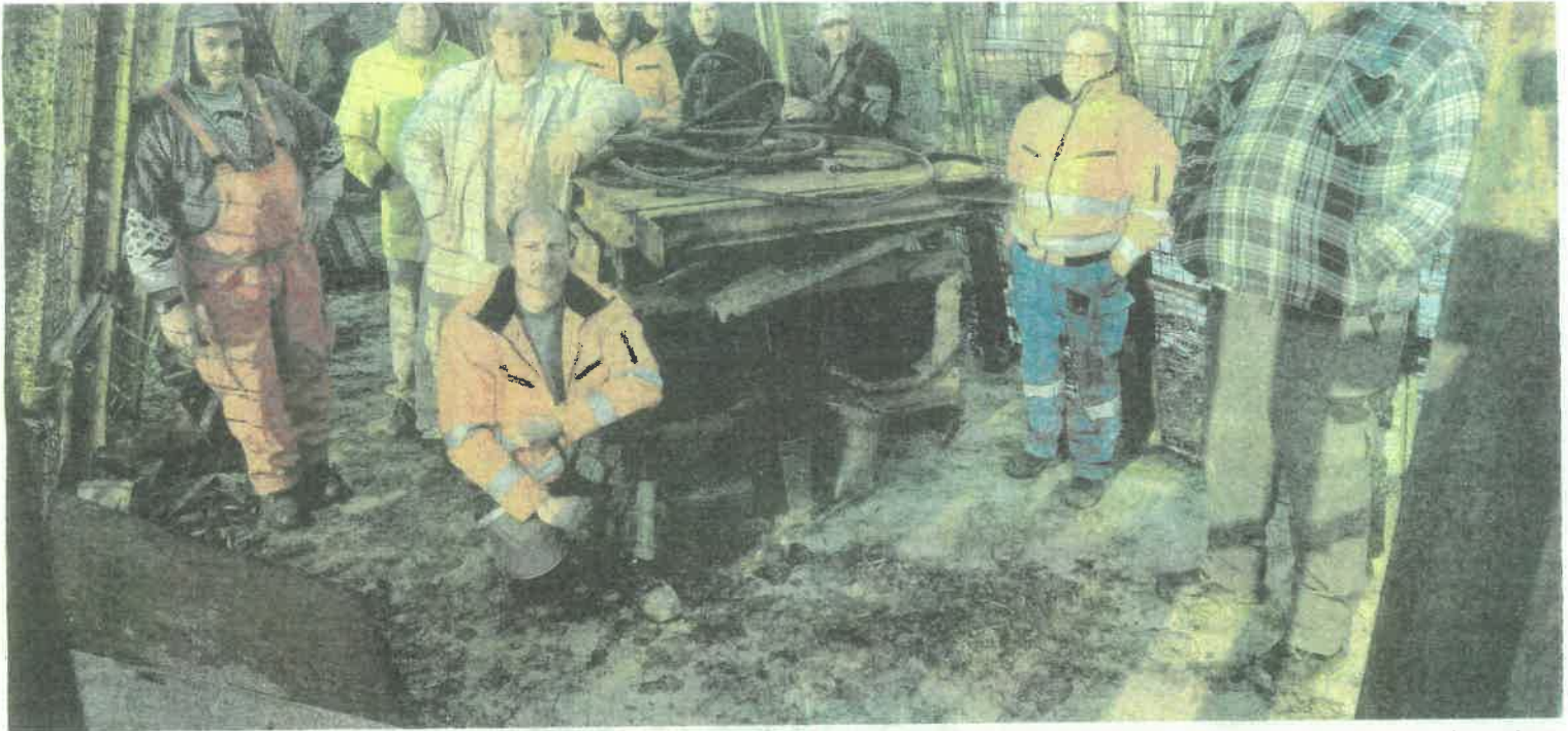
Ein eingeschworenes Team: Jeden Dienstag und jeden Donnerstag wird am Lehrstollen gearbeitet. Gerade bauen sie eine 30 Meter lange Erweiterung, nicht zuletzt, um bei der Landesgartenschau noch besser punkten zu können. Vor Arbeit dürfen sie da nicht weglaufen.
